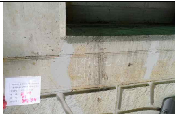
A1 균열 보수
