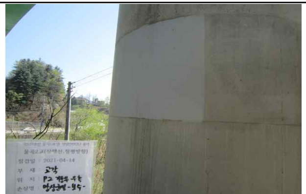
P2 기둥부 망상균열 보수
