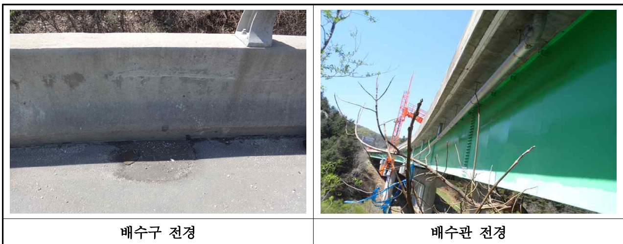
【사진 3.20】 배수시설 전경
