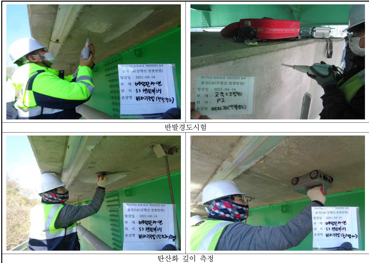
【사진 3.26】 콘크리트 내구성조사 현황
