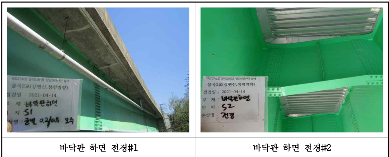
【사진 3.2】 바닥판 전경
