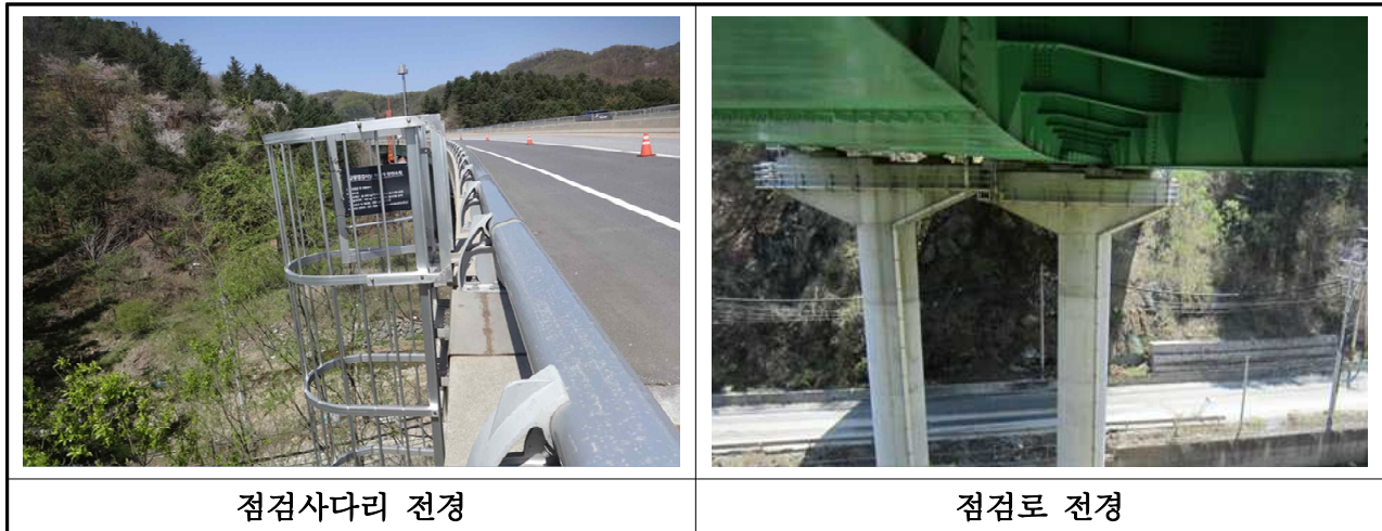
【사진 3.24】 점검로 전경
