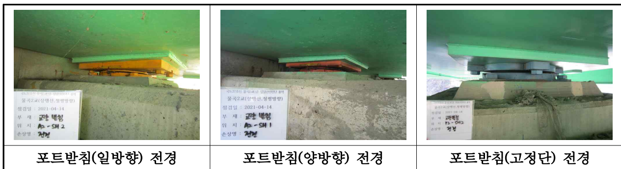
【사진 3.11】 교량받침 전경
