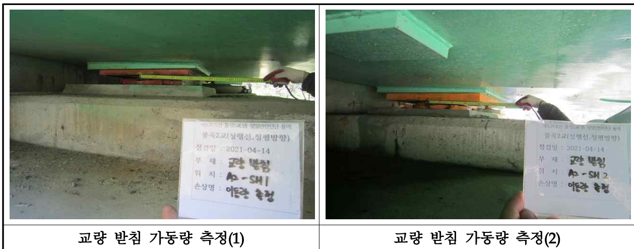
【사진 3.14】 교량받침 이동량 측정
