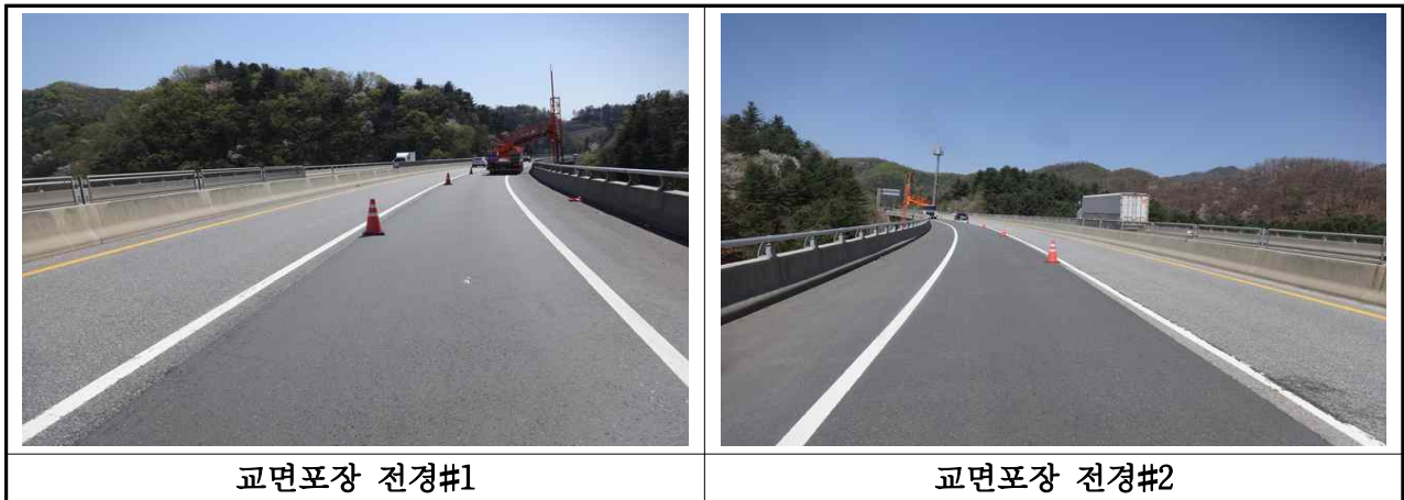
【사진 3.18】 교면포장 전경
